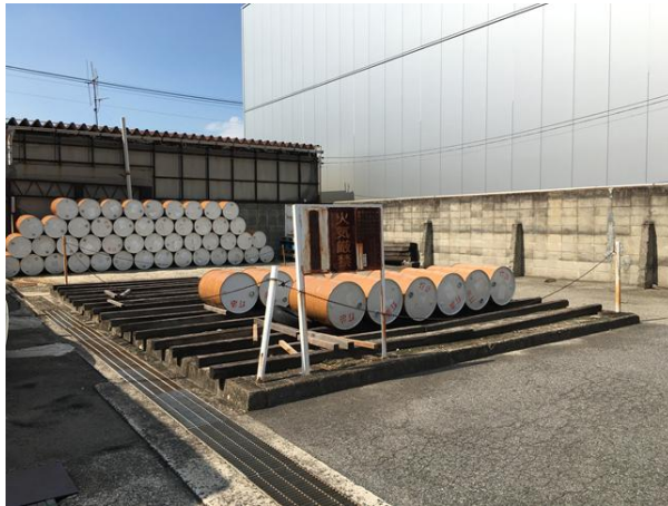
危険物屋外貯蔵所 第4類 3石、4石 48m 2
